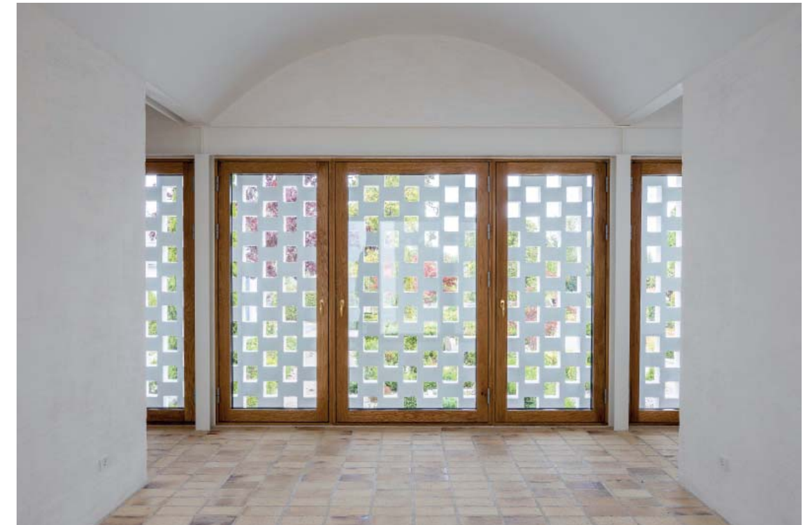
Filtreret kig fra sakristiet til kirkegården gennem det perforerede murværk. Foto: Torben Eskerod
